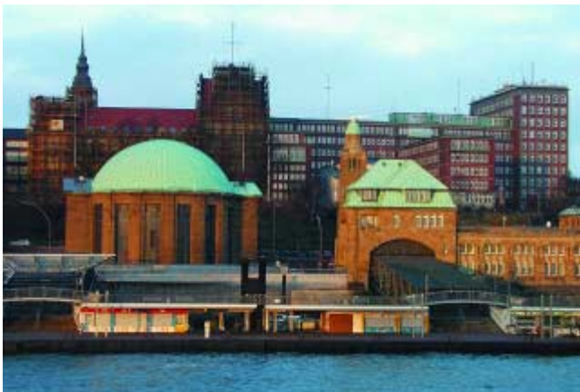
Dienstgebäude in Hamburg
