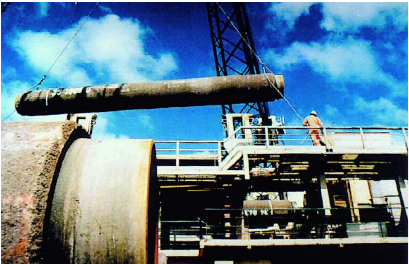
Verlegung einer Pipeline (Abb. mit freundlicher Genehmigung der Fa. Statoil)
