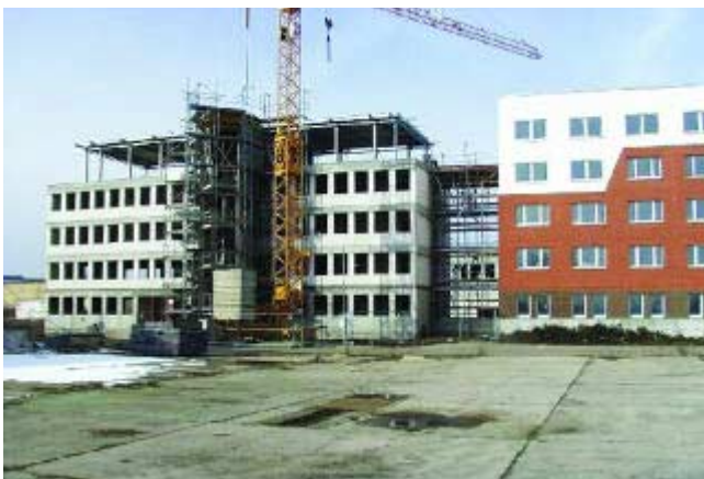
Bau des neuen Dienstgebäudes in Rostock
