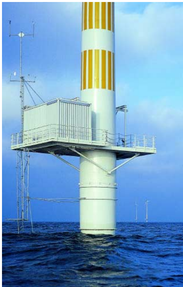
Offshore-Windpark in Schweden (Abb. mit freundlicher Genehmigung der Fa. ENRON)
