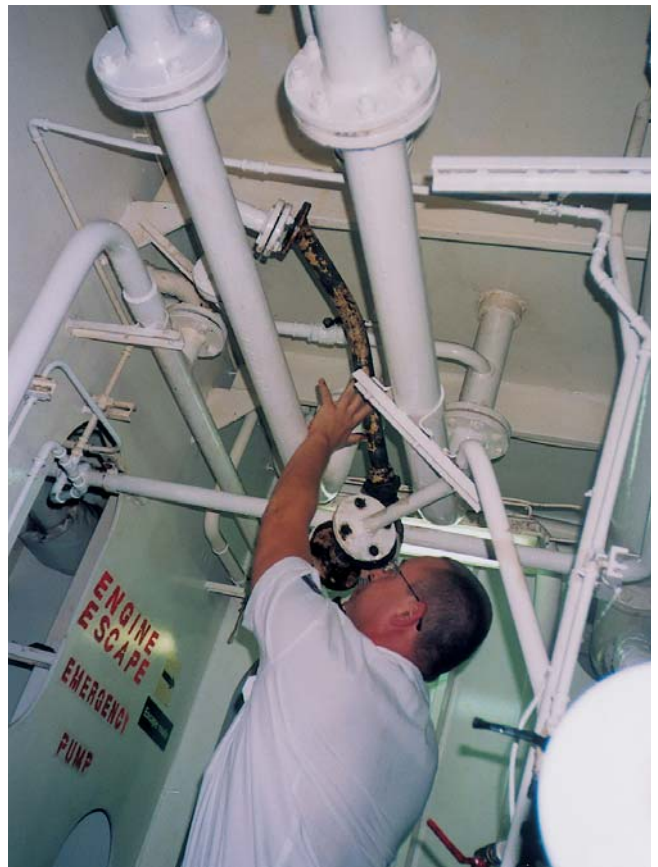
Kontrolle im Maschinenraum (Abb. mit freundlicher Genehmigung der Wasserschutzpolizei Hamburg) Engine room inspection (courtesy of Wasserschutzpolizei Hamburg)
