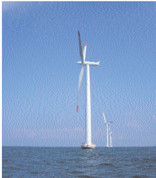
Dänischer Offshore-Windpark Nysted Danish Offshore Wind farm Nysted
