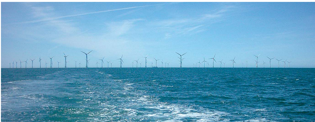
Dänischer Offshore-Windpark „Horns Rev“ · “Horns Rev” offshore wind farm in Denmark
