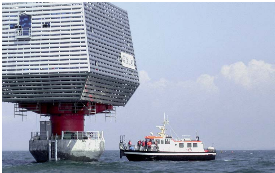
Umspannstation des Offshore-Windparks Nystedt in der dänischen Ostsee Transformer station of Nystedt offshore wind farm in the Baltic Sea of Denmark
