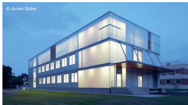
Meereschemisches Speziallabor des BSH in Hamburg-Sülldorf Marine chemistry laboratory of the BSH at Hamburg-Sülldorf
