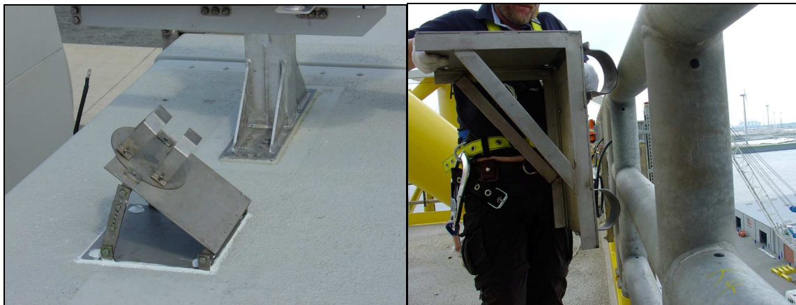
Abbildung 6.4: Kamerahalterung auf der Gondel der R4 (links) und Anpassung der massiven Konstruktion auf dem Plattformdeck der R4 (rechts)
