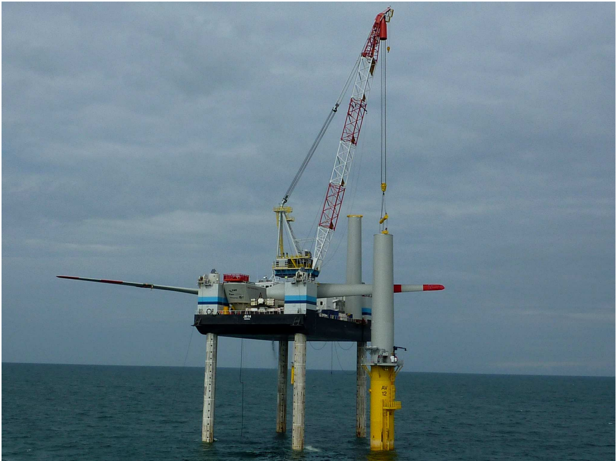
Abbildung 2.1: Beispielhafte Darstellung von Großgeräten auf der Baustelle alpha ventus.
