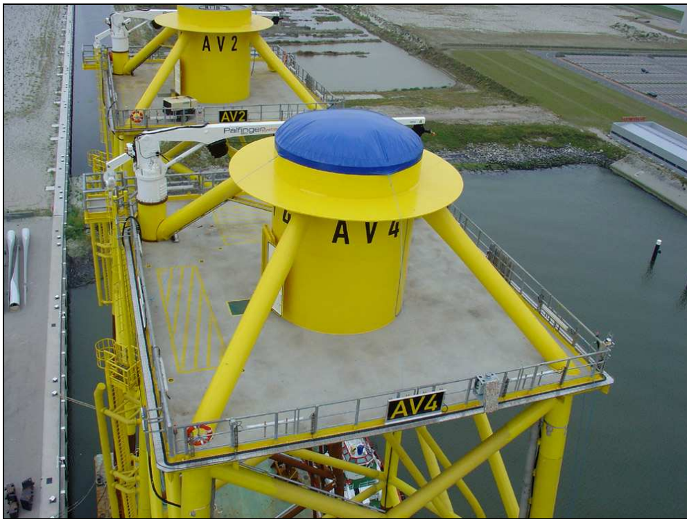
Abbildung 6.5: Plattformdeck der R4 (in Eemshaven). Die Fläche von 14,2 x 16,8 m ermöglicht das Aufsammeln von Totfunden kollidierter Vögel auf definierter Fläche.
